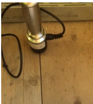
Bild 19. Fuktkvotmätning i springa i bjälklag med hammarelektrod.
