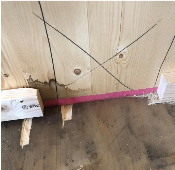
Bild 19. Hus 3, plan 7, provtagning av ovansidan av bjälklag under sylomer, 2019-06-17.
