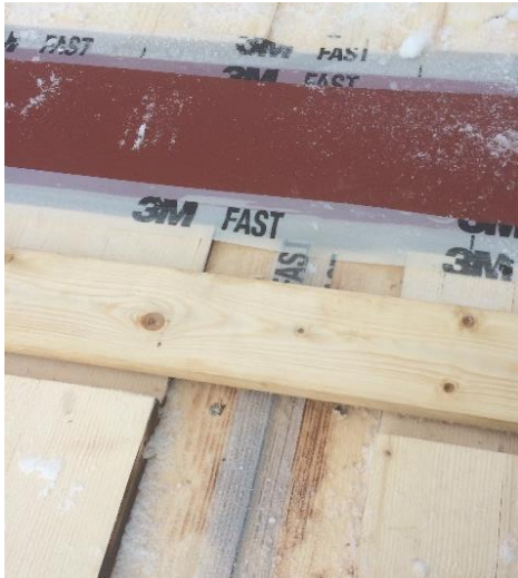
Bild 5. Tejning av skarvar och anslutning mot stålbalk, 2018-02-22.
