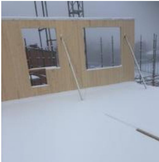
Bild 15. Pågående stomresning av hus 2. Nederbörd i form av snö, 2018-12-07,
