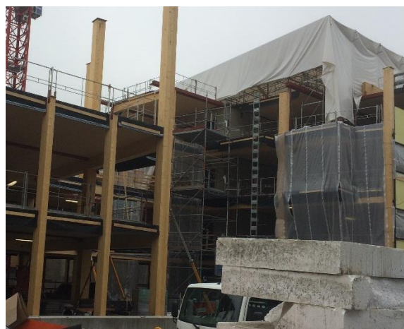
Bild 10. Pågående montage av KL-trästomme i etapp 2. Till höger syns etapp 1 med delvis väderskydd.
