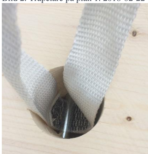
Bild 4. Infästning för lyftögla, 2018-02-22
