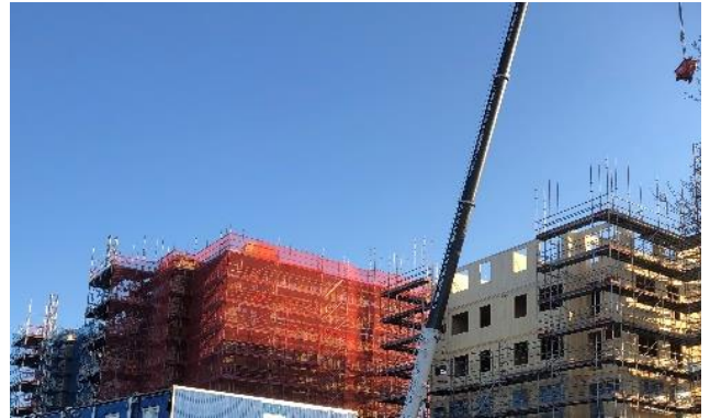
Bild 16. Pågående stomresning av hus 1, 2019-04-09. På de andra två husen syns röd ställningsväv.
