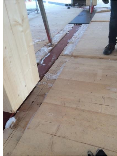
Bild 6. Täckning av skarv med plywood och tejp 2018-02-22.
