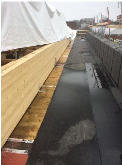
Bild 7. Delvis täckning av terrass med papp samt delvis ett tält över plan 5, 2018-04-16
