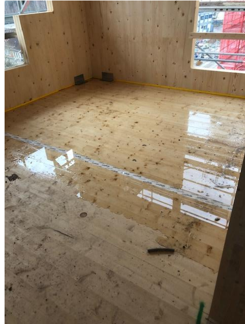
Bild 26. Hus 3, plan 5. Pågående stomresning på plan 6. Vatten på bjälklag, 2019-02-19.
