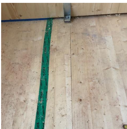
Bild 23. Skarvarna i bjälklaget tätades med tejp.
